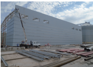
精米工場建設の様子
