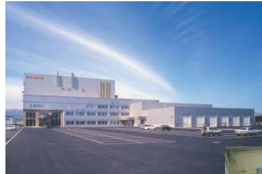
日本最大・最新鋭の精米工場、平成14年5月31日竣工したホクレンパールライス工場。「安全・安心・美味しい」がコンセプト。
