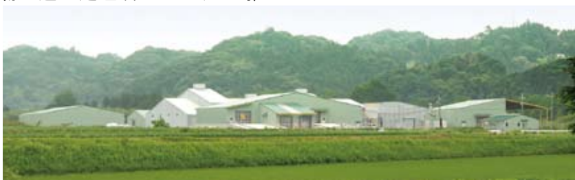
鹿沼市堆肥化センター全景
